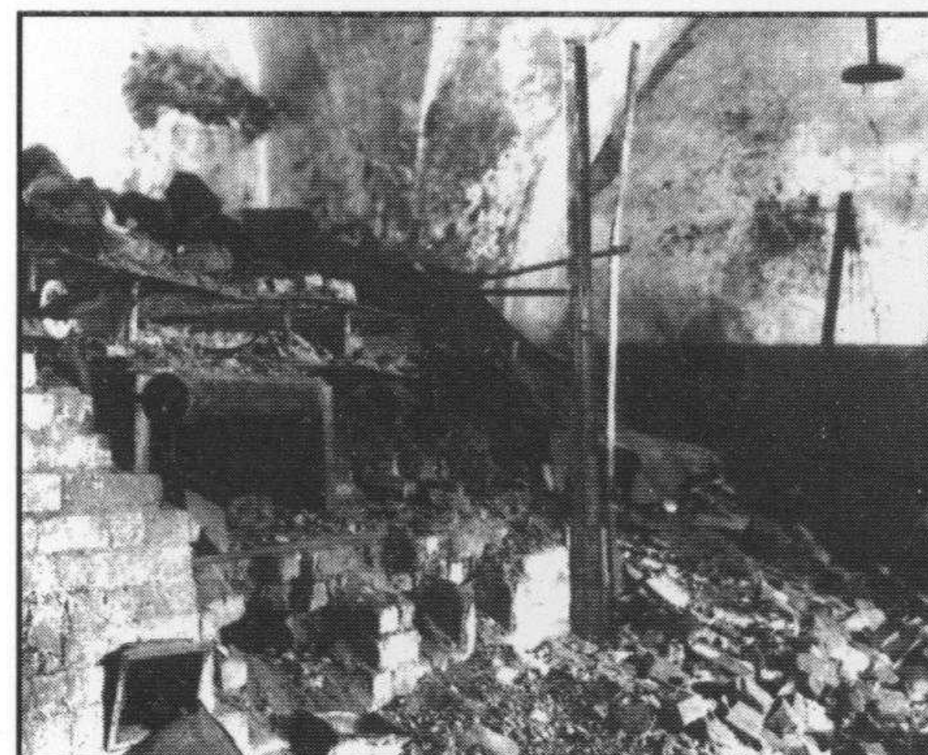
Внутренний вид пекарни, разрушенной немцами.
